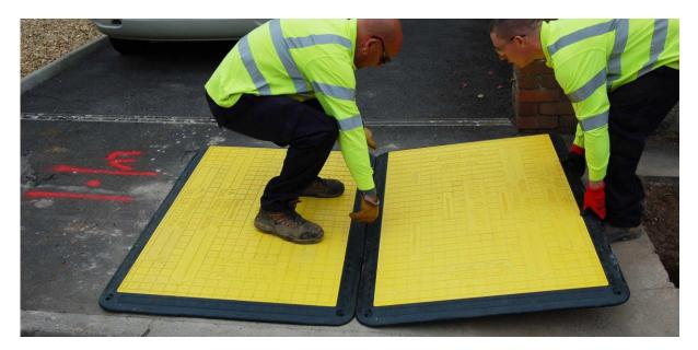
Für die Herstellung barrierefreier Übergänge bei Hochbordsteinen ist die SafekerbRamp gedacht. Mit dieser können Höhenunterschiede bis 0,16 m überwunden werden. Diese Rampe ist rutschsicher, leicht zu verlegen und kann im Asphalt fixiert werden. Soll ein provisorischer Fußgängerüberweg für eine Baustelle erstellt werden, kann mit der SafekerbRamp der barrierefreie Übergang erstellt werden und der Zebrastreifen mit unserer ClearPath Mat ausgelegt werden.
